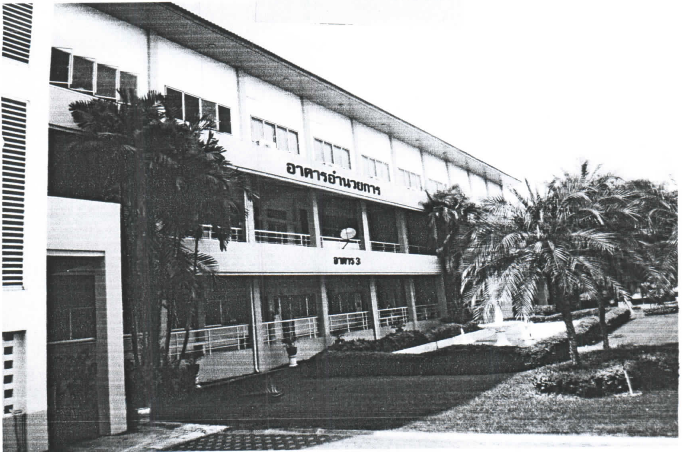
อาคารอำนวยการ
